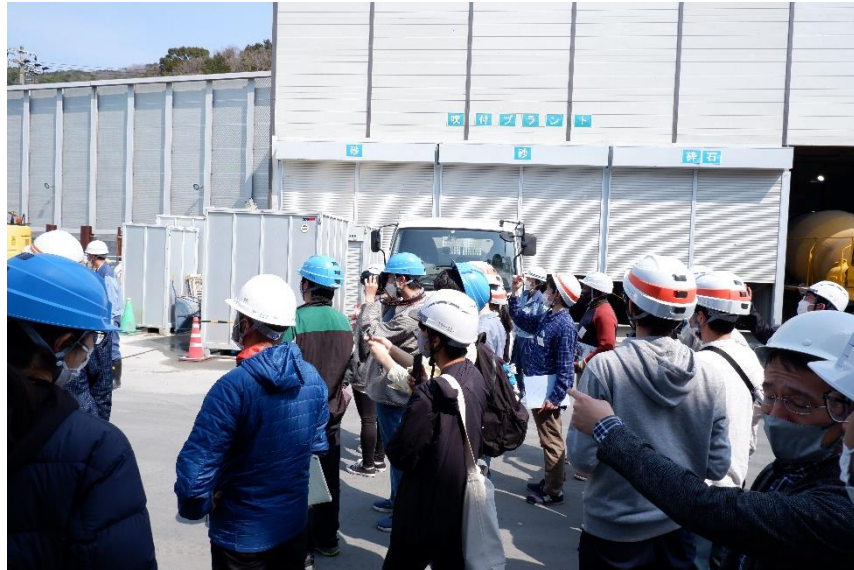
図 4 西部幹線併設水路御津工区工事現場にてずり出しを見る参加者 (写真撮影・掲載許可確認済み)
