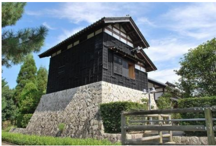
図1 水屋(木曾三川公園センター)
