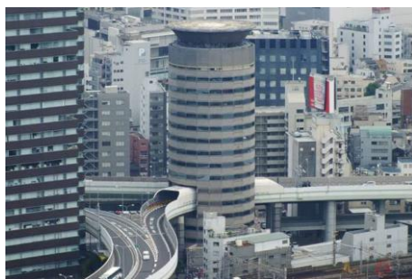
図1 11号池田線梅田出口付近
