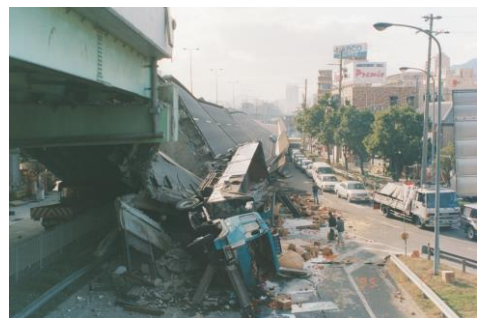
写真 1 崩壊した国道 43 号線バイパス道路(灘区) 1)
