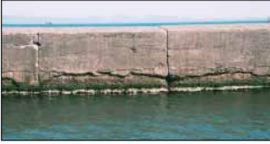
図 3.4 ケーソンにより築造された島防波堤
