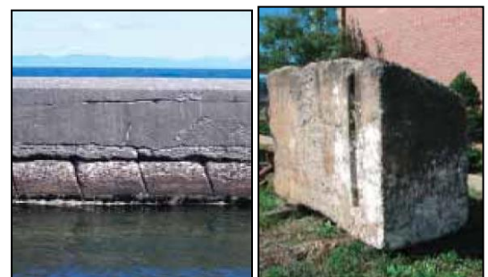
図 3.2、3.3 斜め積みのブロックと引き上げられたブロック
