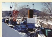
ジャイロプレス工法【φ2000】(平成28年3月)
