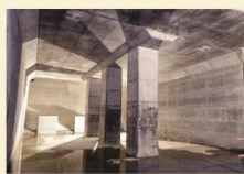
舌口本体工:導水路BOX部(平成29年3月)
