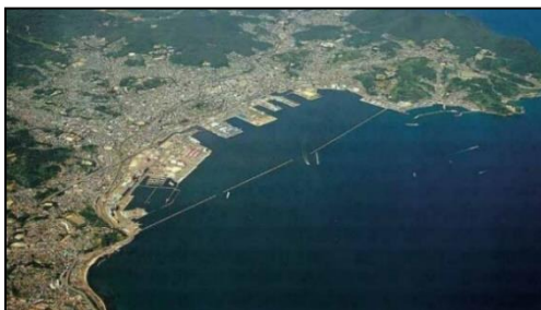
図 3.1 小樽港の全景
