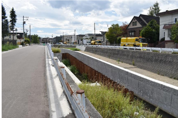
図 3.1.1 平常時の望月寒川（放水路呑口部）
