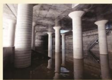
舌口本体工:沈砂池部(平成29年3月)
