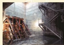
舌口本体工:導水路立坑部(平成29年3月)
