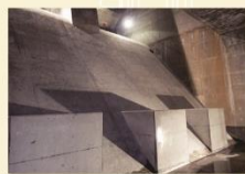
舌口本体工:導水路落着工部(平成29年3月)
