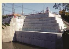
箱型壁設置(平成28年5月)
