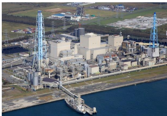
図 12.1 苫東厚真火力発電所
