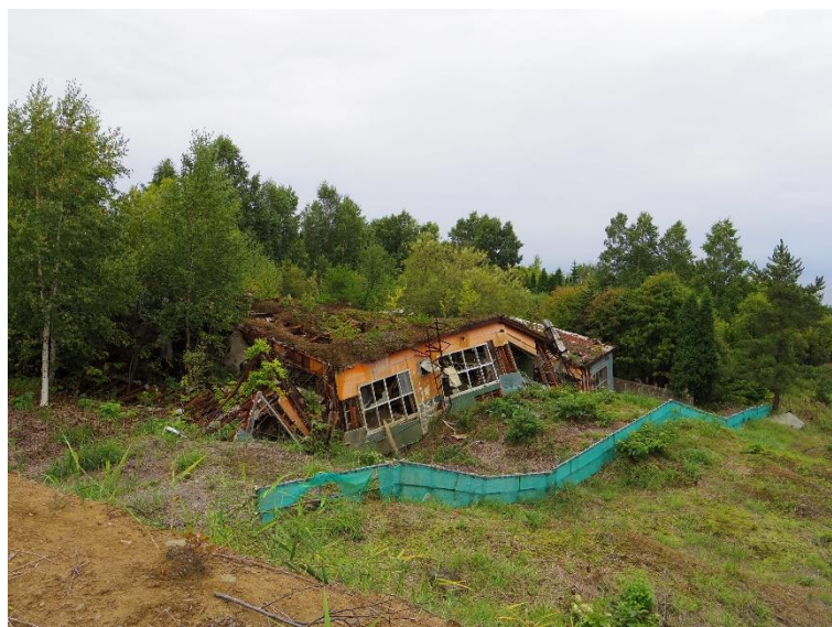
図 3.3.2 噴火によって大きな被害を受けた建物
