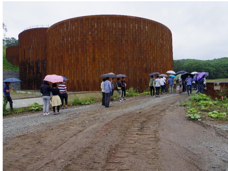
図 3.3.7 砂防堰堤を間近で見学する参加者
