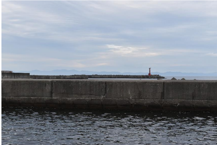
図 3.1.11 小樽港北防波堤
