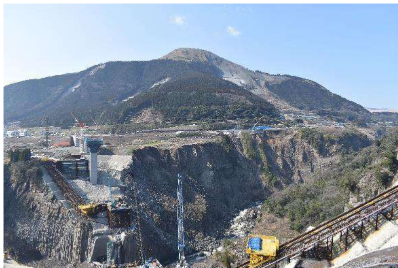
図 3.2.8 新しい阿蘇大橋の建設現場
