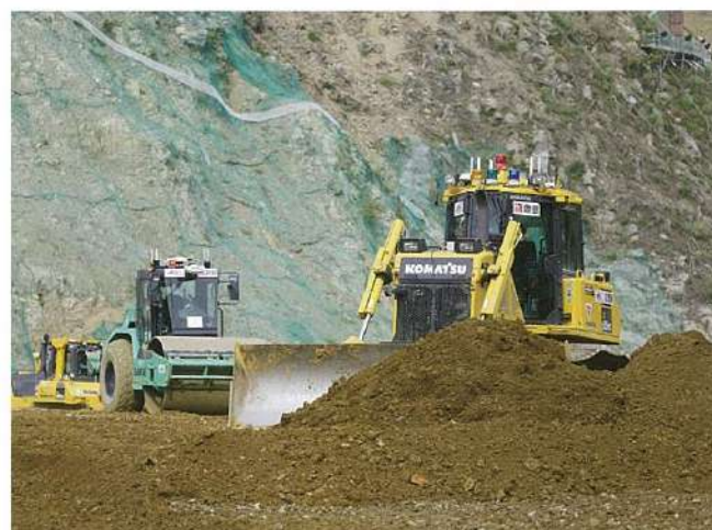
A 4 CSELによる盛立作業。熟練オペレータの運転データを収集・分析し、精度の高い自動運転を実現
