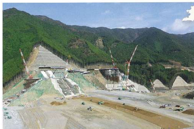
堤体盛立工事が最盛期を迎えた小石原川ダム
