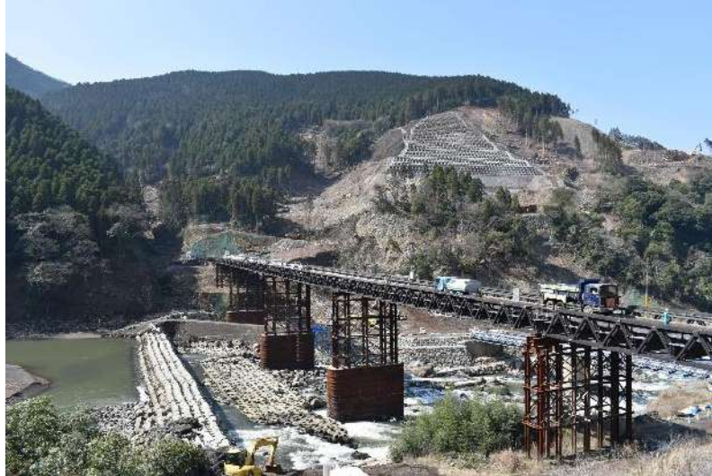
図 3.2.5 仮橋を設置し工事が進む立野ダム
