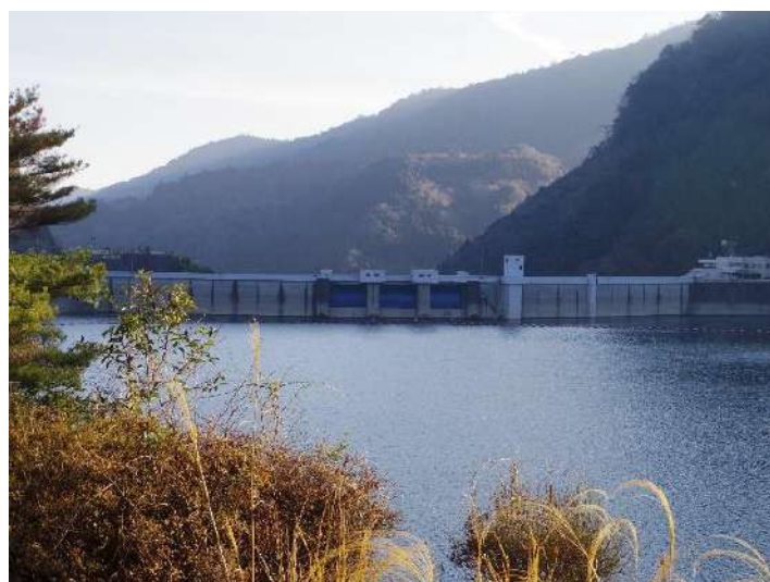
図 3.3.2 下笠ダム（アーチ式ダム）
