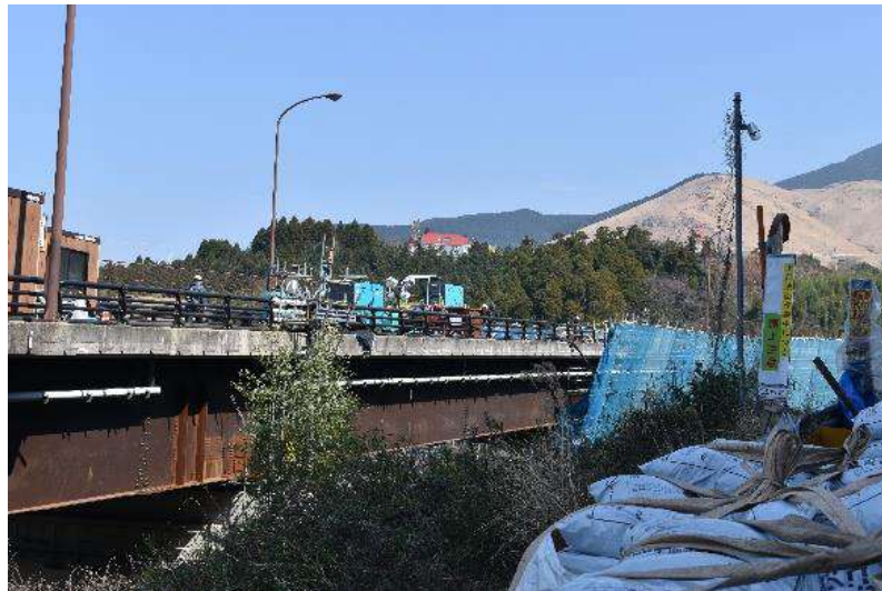
図 3.2.6 復旧工事が進む大切畑大橋
