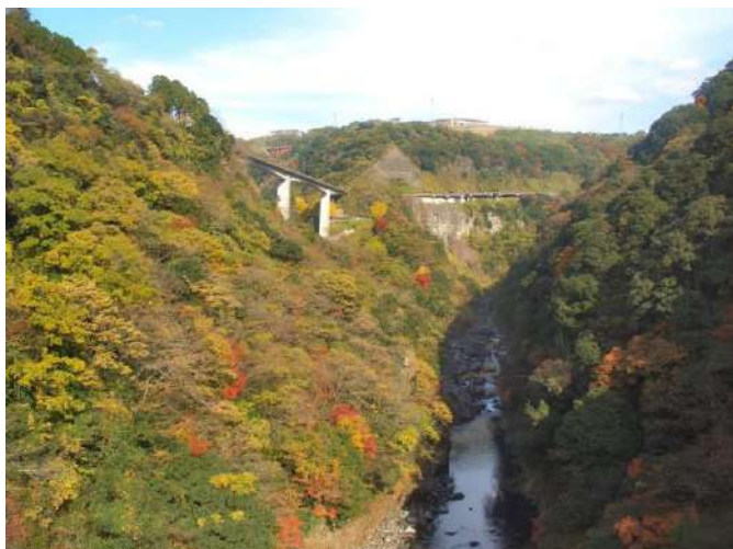
図 9.1 左側の橋が阿蘇長陽大橋、奥が戸下大橋
