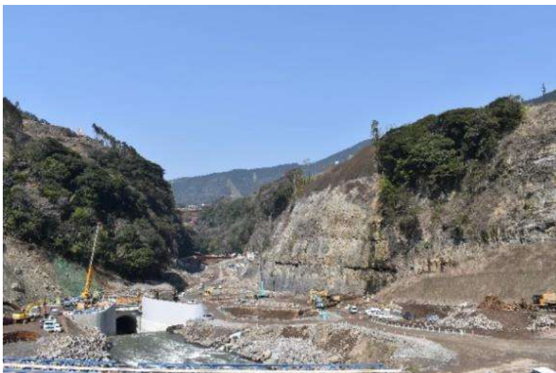
図 3.2.3 立野ダム建設現場より下流側を見る
