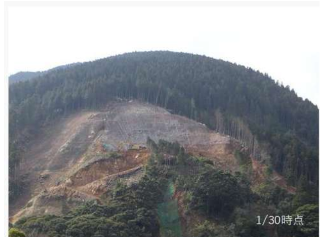
図 6.3 堤体基礎掘削工の様子（1 月 30 日現在）
