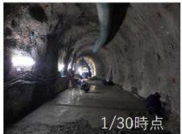
図 6.4 右岸リムトンネルの様子（1 月 30 日現在）
