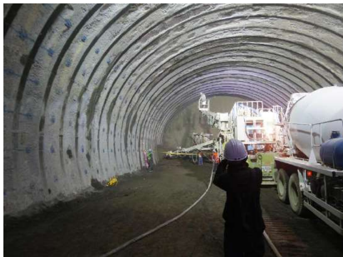
図 3.1.12 掘削している様子
