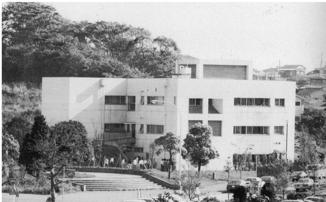
1984 年ごろの土木棟周辺（3 期生が植えた桜の若木が確認できる）
