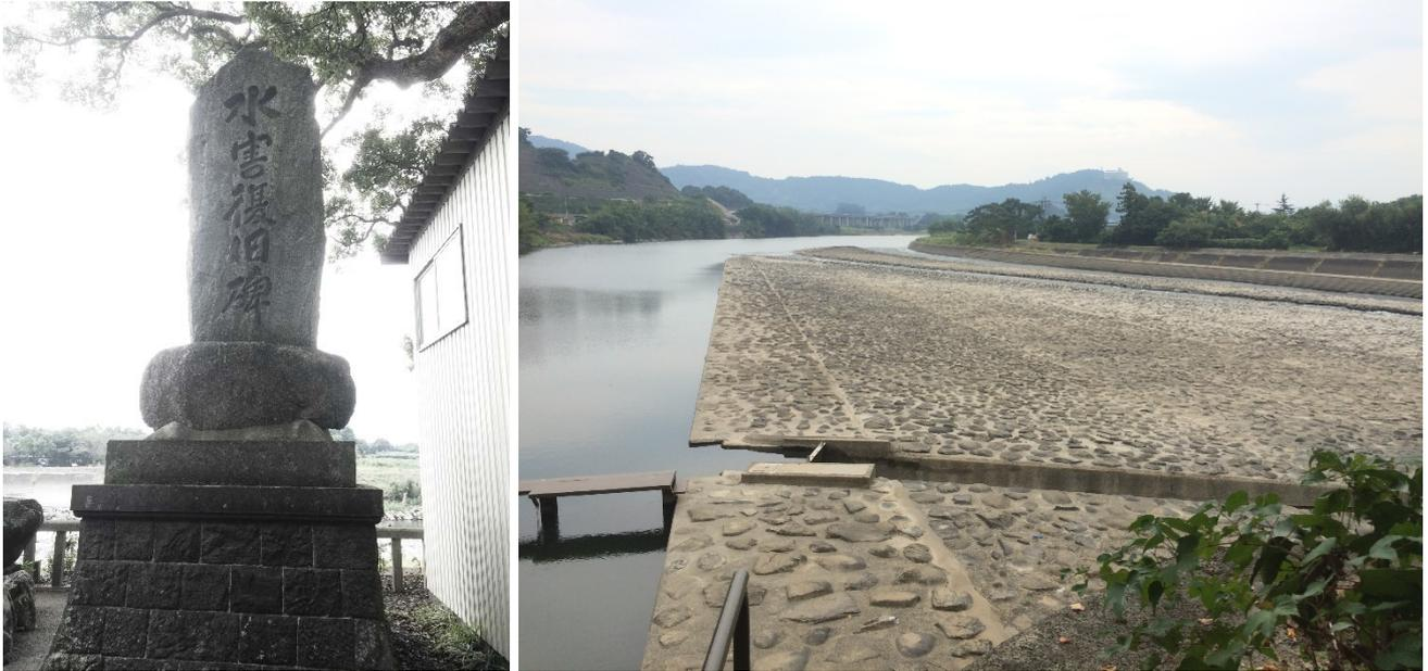
2日目の午前は、大分県から福岡県へと移動した後、筑後川中流に位置する山田堰で締めくくりとなりました。これは、土木学会の土木遺産にも登録されており、農業土木学でいう「頭首工」という水利構造物で、その構造形式は、傾斜堰床式石張堰と呼ばれ、日本唯一の方式となっています。特徴としては、堰前壁を水筋（みおすじ）に対し約20度の角度をもって斜めに配置し、水流が激しい筑後川の水圧を緩和する治水構造としていること、突き当たりの取水口へ水流が勢いよく行かないように、河川水を導流するために高低差のある構造物をうまく配置していること、舟通しと魚道、土砂吐きからの水流を堰の末端部で合流させて減勢させる構造を作り出していることの3点が挙げられます。
