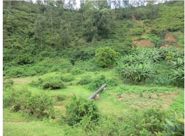
取水施設から浄水場へ向うパイプ。
