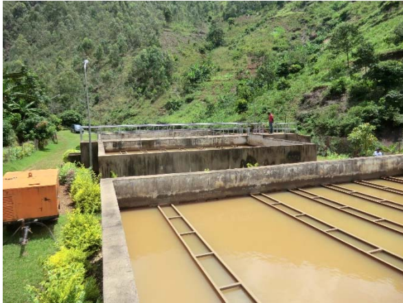
Yanze River にある 1 次処理施設. 泥質分を沈殿させるものであるが, それほどの効果はなさそうです.
