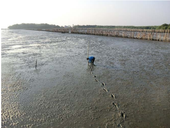
波浪計の設置
