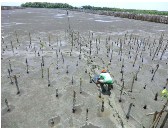
Bamboo siteでの波浪計の設置。設置は、このSiteを運営されている方にお願ひしました。
