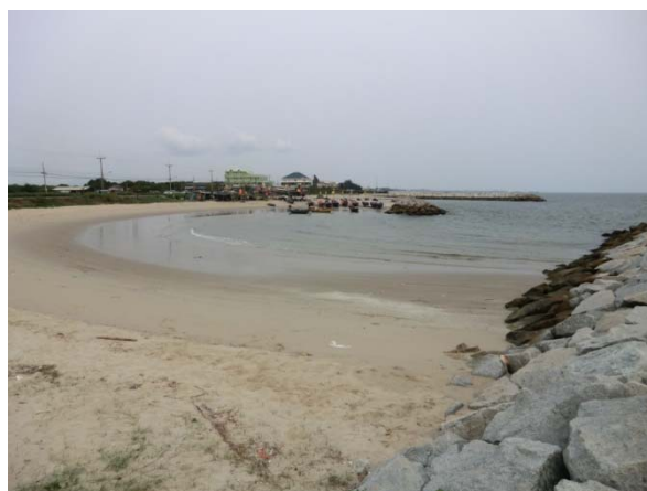
離岸堤が設置された海岸。背後は多く堆砂していた。
