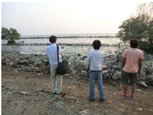
この場所では、竹により侵食を防ぐ対策が行われていた。
