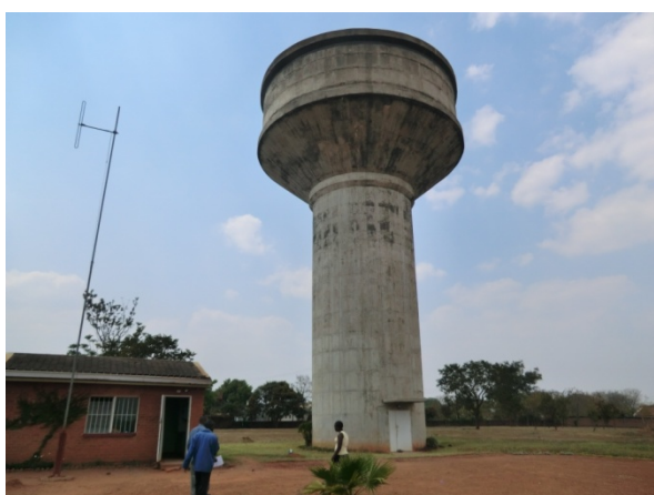
Maliano 君の研究ターゲットである Area9 の貯水タンク.
